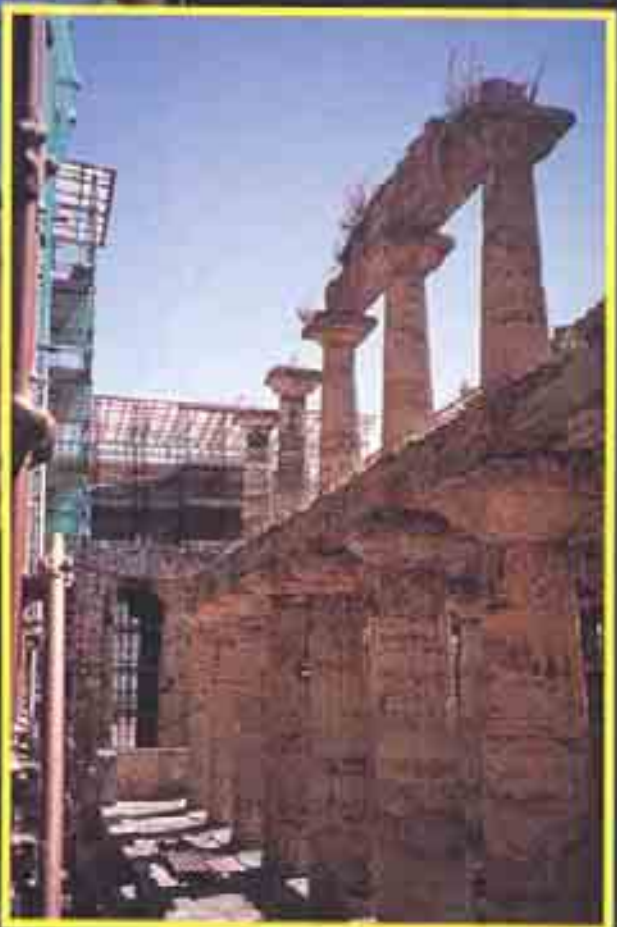
A sinistra: una fase della pulitura: asportazione degli occinuli di terra dalle superfici sommitali e dagli spioventi del tempio.
