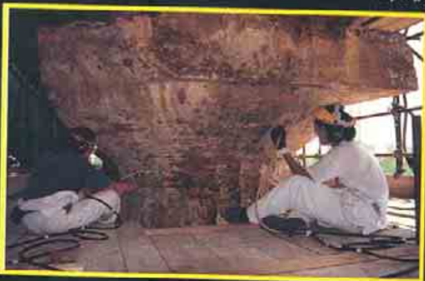
Un momento della pulitura con strumenti micropneumatici di precisione.
