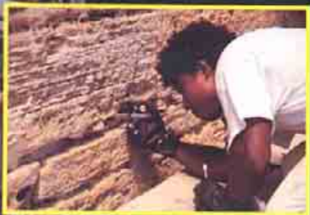
Qui sopra: una fase del restauro: lo stuccatore delle lacune del travertino.
