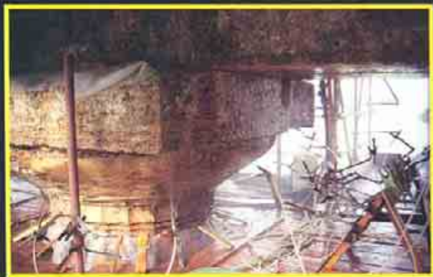
Pulitura delle superfici con un sistema di acqua nebulizzata.
