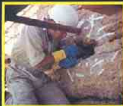
Un restauratore al lavoro sulle strutture del tempio.
